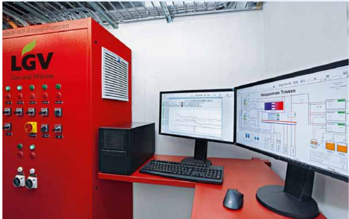
Prozessleitsystem der Heizzentrale: Die Hoval AG ist der kompetente, innovative Partner für das technische Know-how sowie die Inbetriebnahme der Energieerzeugungs- und Energieversorgungsanlagen.
