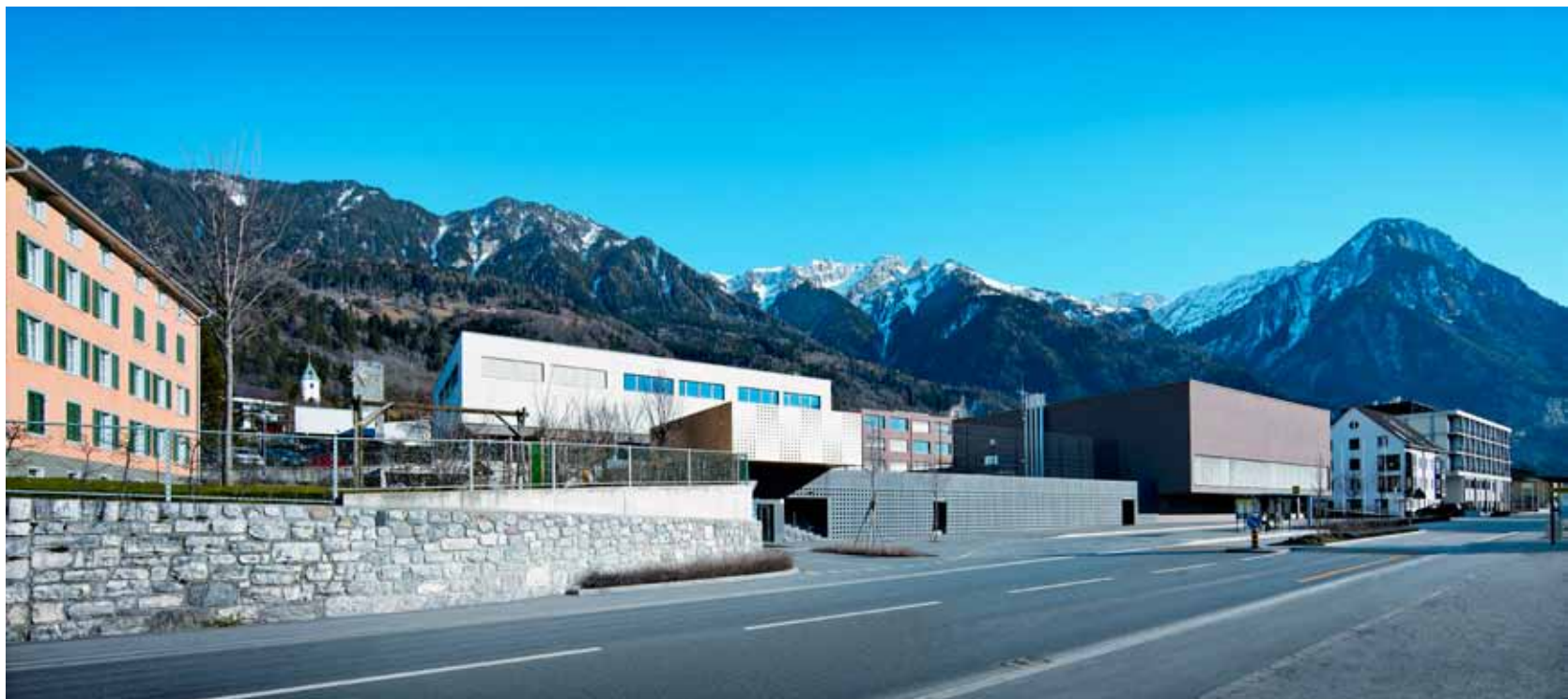
Mit dem Wärmeversorgungsnetz im Zentrum von Triesen werden eine Reihe von öffentlichen und privaten Gebäuden mit thermischer Energie versorgt.
