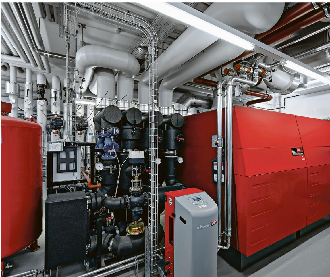
Heizzentrale mit Gas-Brennwertkesseln der LGV bei der Schekolin AG, «Bendern Industrie».
