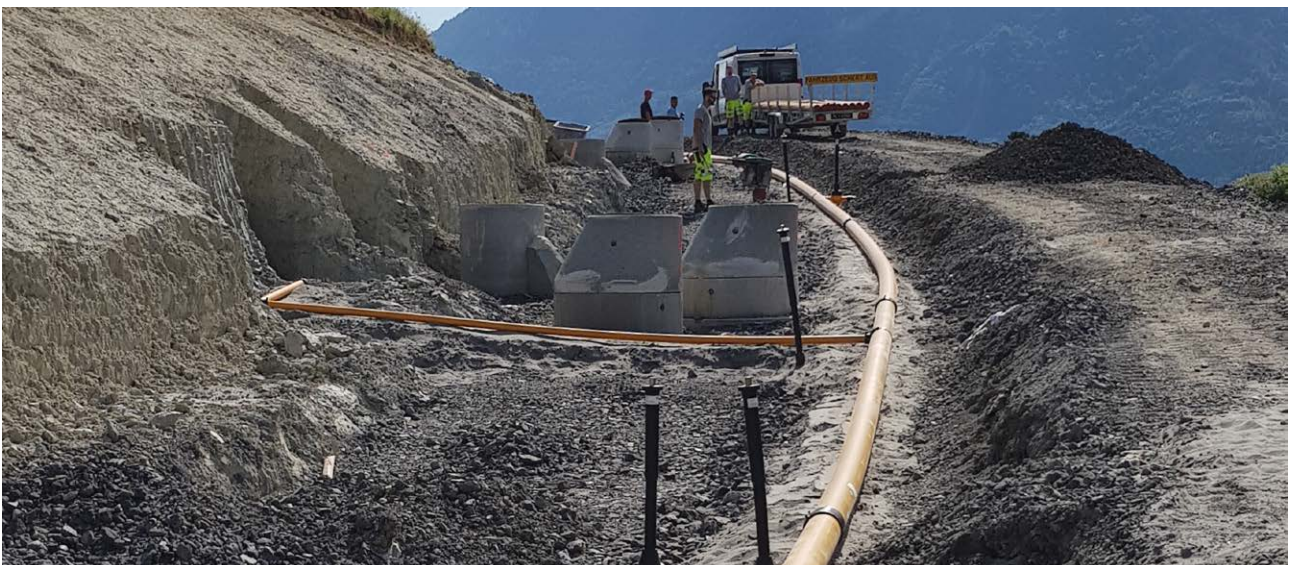
Gasleitungsbau in Eschen
