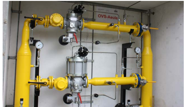
Gas-Ortsversorgungsstation Bendern Äule
