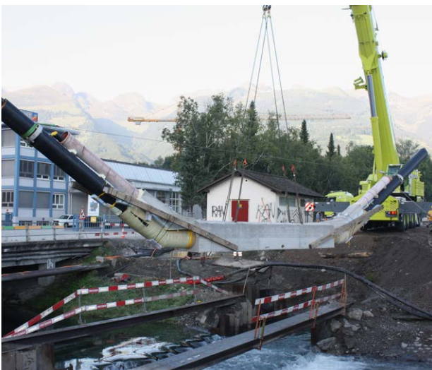
Fernwärmeversorgung Schaan – Düker der Hauptleitung bei der Zollstrasse
