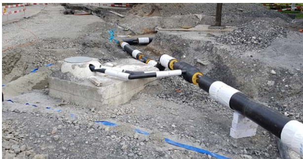
Wärmeversorgung Eschen – Leitungsverlegung
