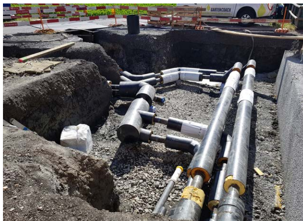
Wärmeversorgung Bendorf Industrie – Neubau der Transportleitung
